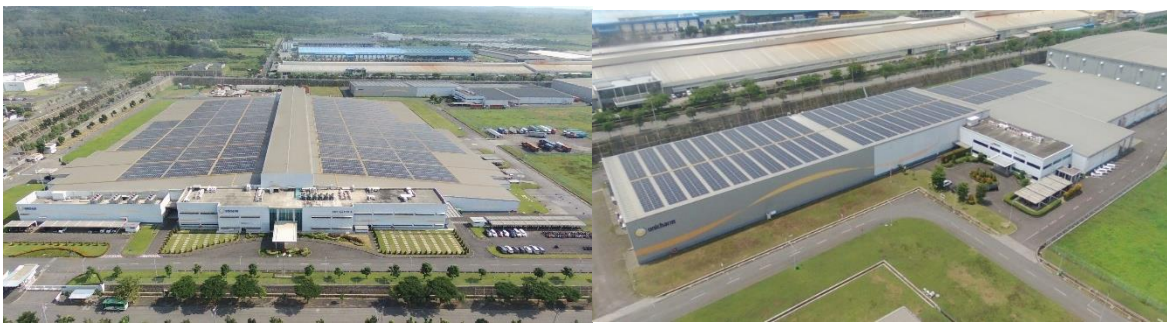
Pembangkit listrik tenaga surya di UCI East Java Factory (kiri) dan Unicharm Non-Woven Indonesia (kanan) yang mulai beroperasi bulan Juli 2023
